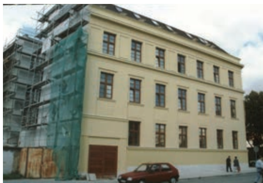
Budova dostala nový vzhled
