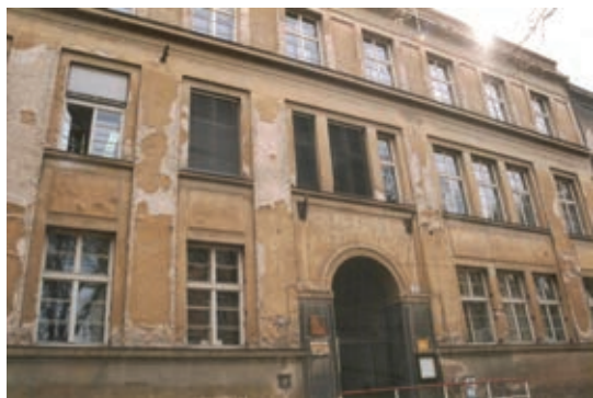
Čelní pohled na starou budovu gymnázia
