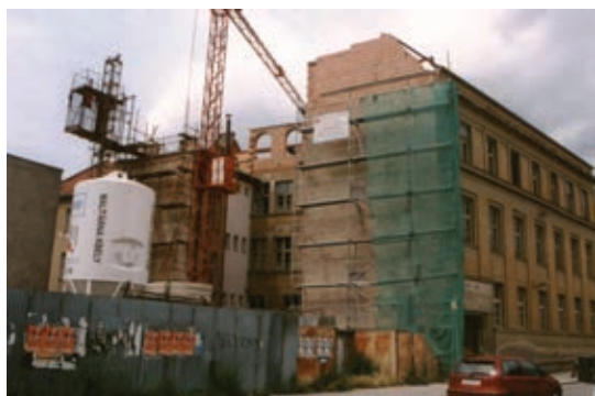
Spolu s rekonstrukcí probíhala i přístavba čtvrtého patra
