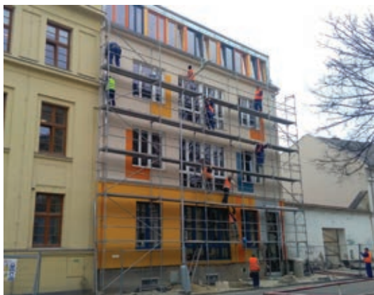
Poslední venkovní úpravy na základní škole
