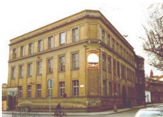
Pohled na budovu gymnázia před rekonstrukcí
